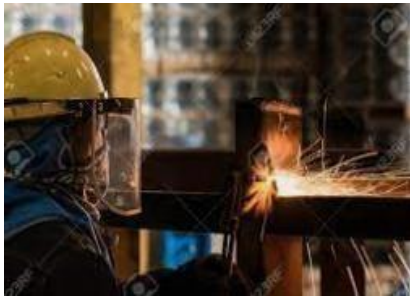
Soldadura y corte con soplete de gas
