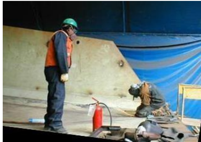
Operario de trabajo en caliente
